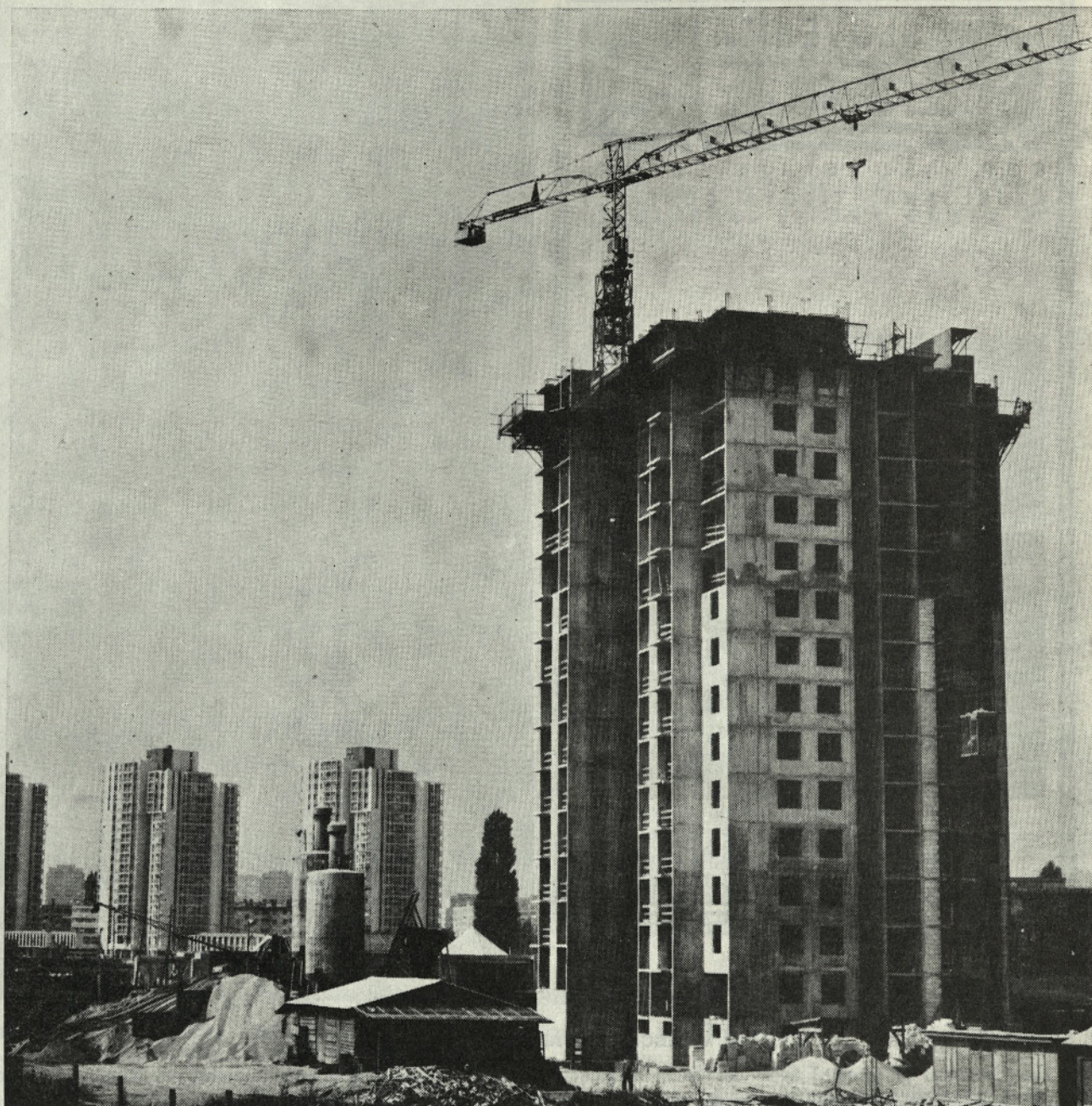
Gradbišča stanovanjskih blokov v Zagrebu
