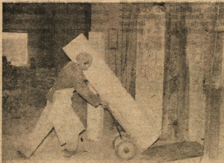
Pred retort vstavijo v topilniške peči, jih morajo v temperaturni peči segreti na določeno temperaturo. Na sliki — vlaganje retort v temperaturno peč.
