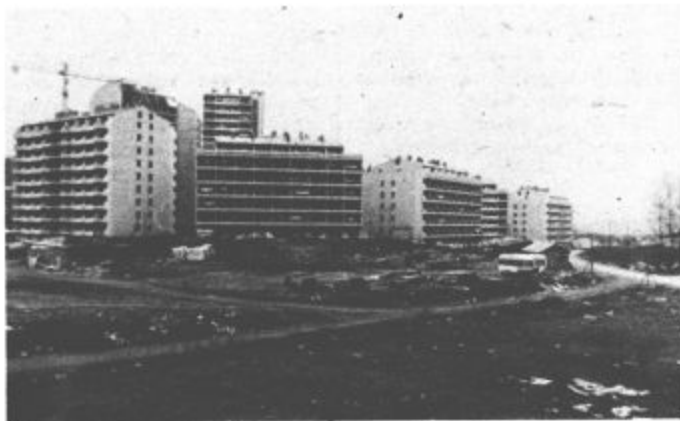
Del krajevne skupnosti Šalek Gorica med gradnjo
