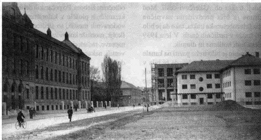
Gradnja stare stavbe sedanje Fakultete za strojništvo; spredaj: travnik, kjer je sedaj Filozofska fakulteta; levo: sedanja Srednja tehnična šola
