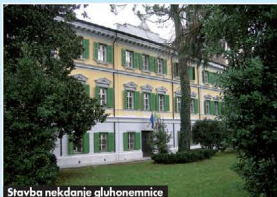
Stavba nekdanje gluhonemnice
