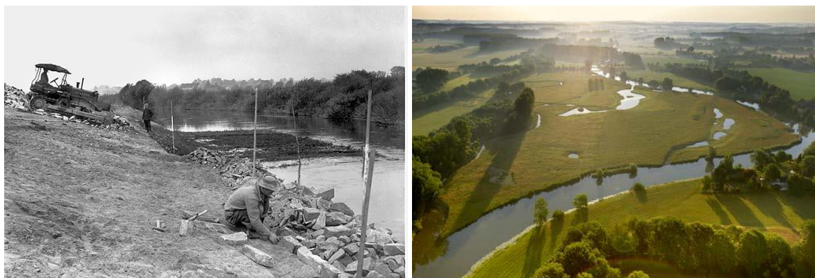
Slika 99: Regulacija reke Lippe blizu Hamma med letoma 1958–1968 ter krajina po izvedenem projektu renaturacije (Barden, 2013).
