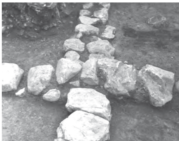
Sl. 28: Hiša 1. Predelni zid in severozahodni zid gradbene faze 2; pogled s severozahoda.
