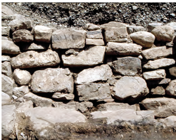
Sl. 104: Hiša 15. Severni drenažni zid; pogled z juga.
