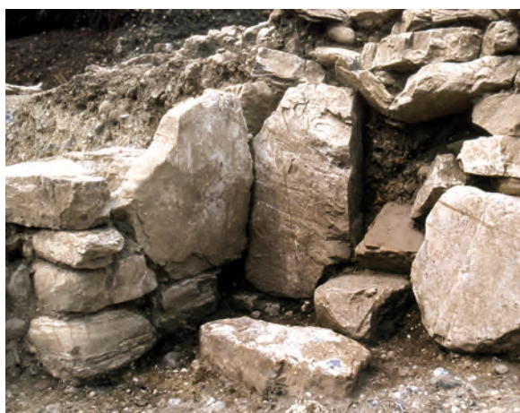
Sl. 154: Hiša 22. Gradbena faza 1, severozahodni kot drenažnega zidu; pogled z jugovzhoda. Fig. 154: House 22. Construction Phase 1, northwest corner of the drainage wall; view from the southeast.
