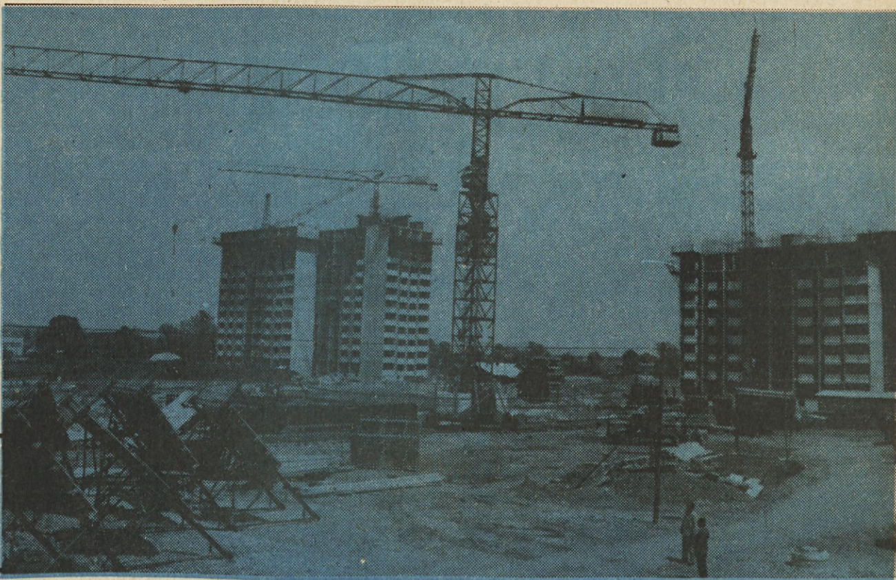
Na gradbišču Štepanjsko naselje naši monterji že izvajajo vse instalacije
