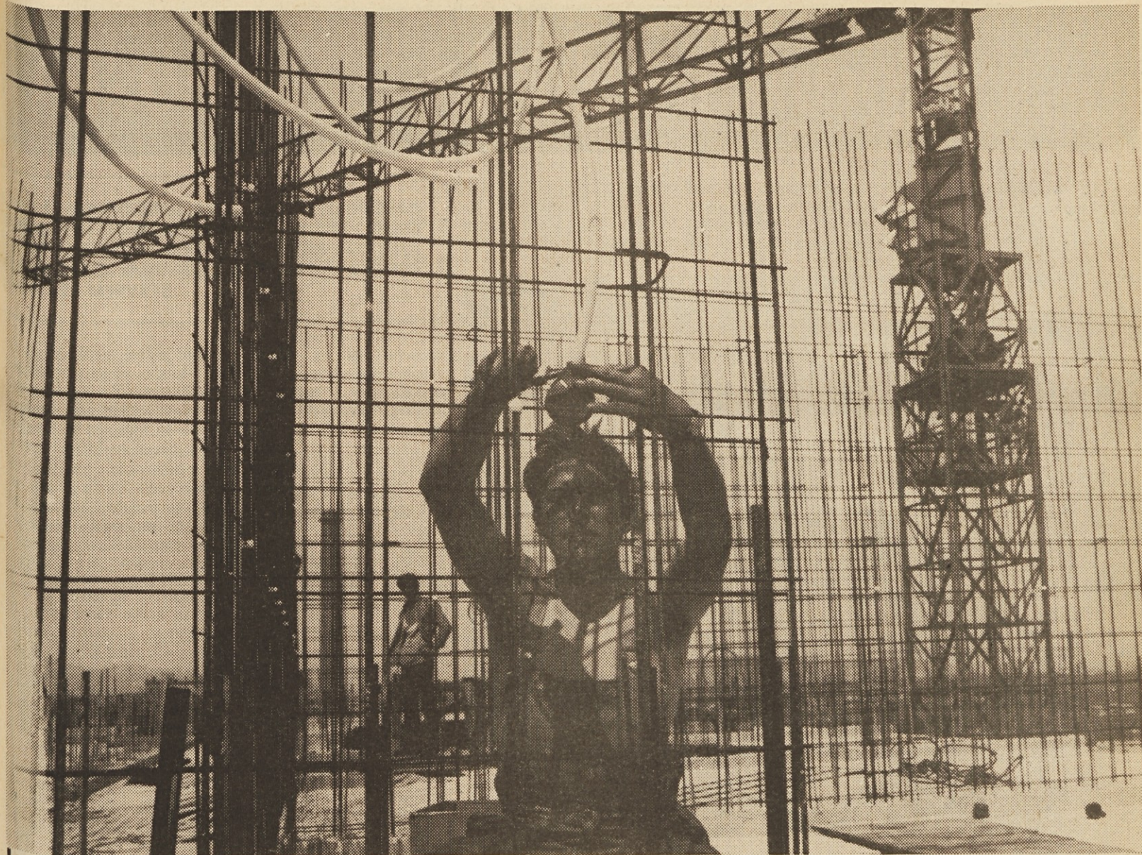
Tone Berčič napeljuje električne instalacije na stolpnici SO-I v Štepanjskem naselju
