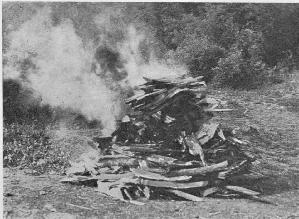
Slika 4. Prižgana kopa za oglje, Janko Hudorovac, kovač, Rosalnice pri Metliki
