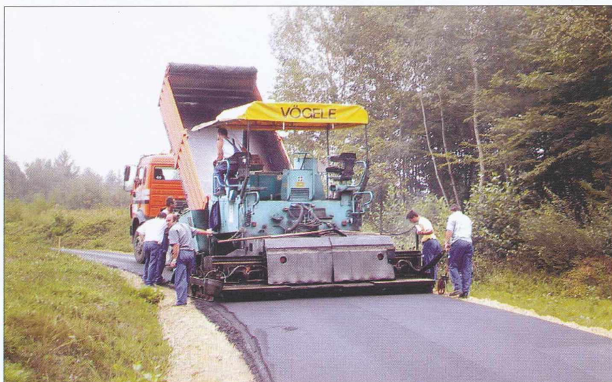
Asfaltiranje občinske ceste v Kruplivniku.
