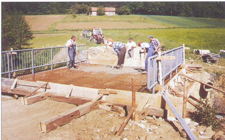
Gradbena dela pri prenovi mostu v Kruplivniku.
