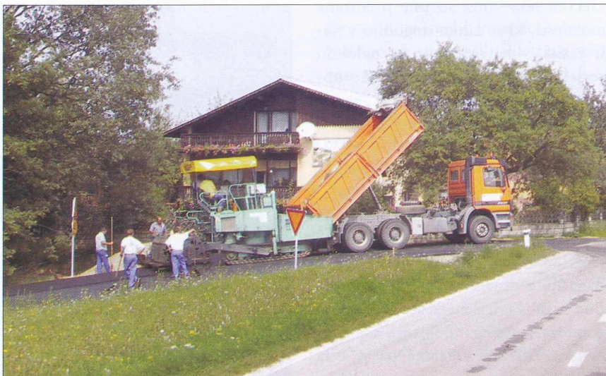
Priključitev na cesto v Radovcih.
