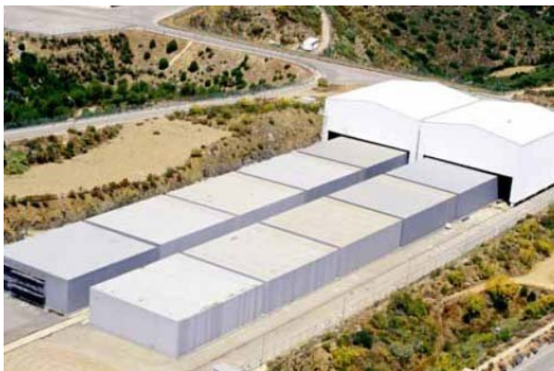
Slika 3: Napolnjeni in z AB ploščo zaprti moduli.
