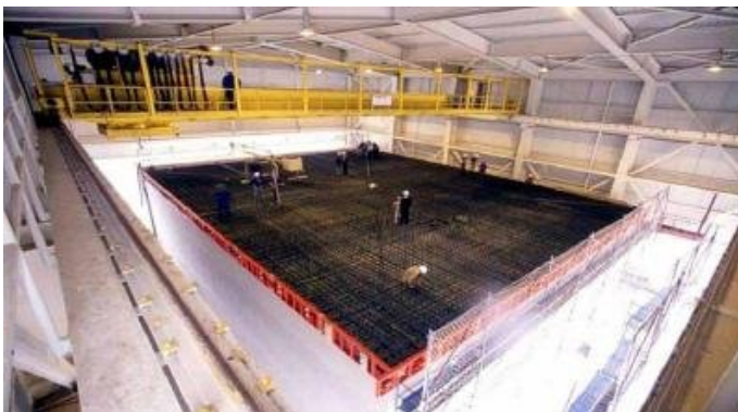
Slika 5: Polaganje armature krovne AB plošče.
