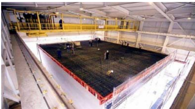
Slika 5: Polaganje armature krovne AB plošče.
