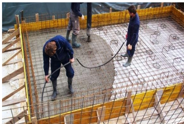
Slika 6: Vibriranje betona
