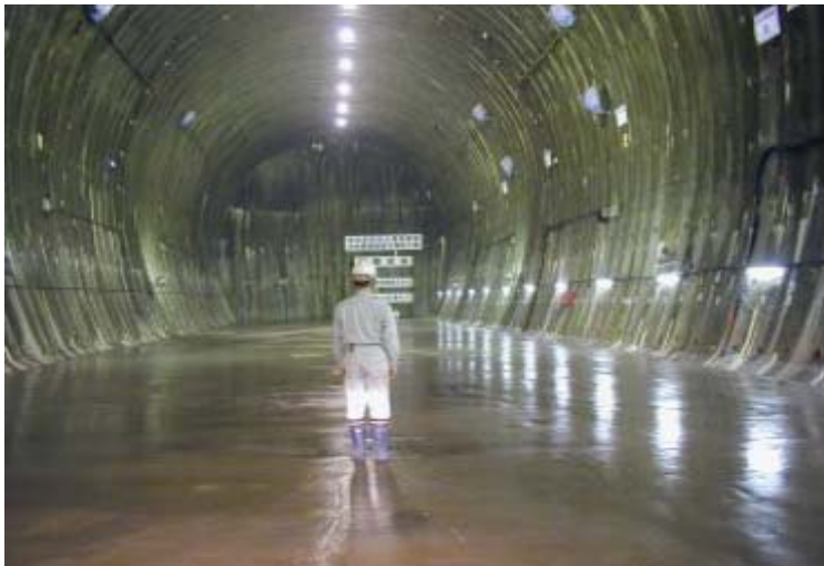
Slika 8: Primer izvedbe rova za odlaganje RAO.
