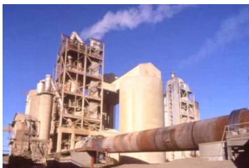
Slika 1: Rotacijska peč in cementni grad [1]
