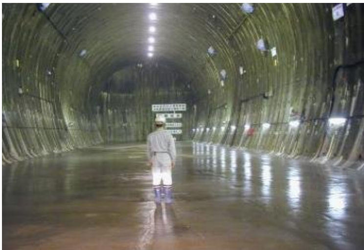
Slika 8: Primer izvedbe rova za odlaganje RAO.
