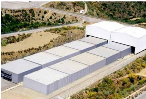
Slika 3: Napoljeni in z AB ploščo zaprti moduli.
