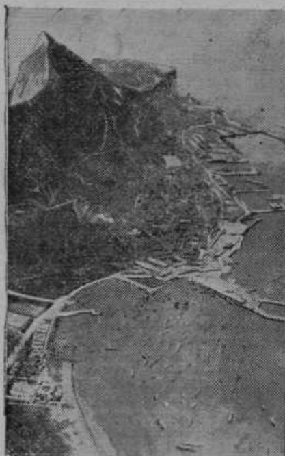
Angleška trdnjava Gibraltar, ki je ključ do Sredozemskega morja na zapadu
