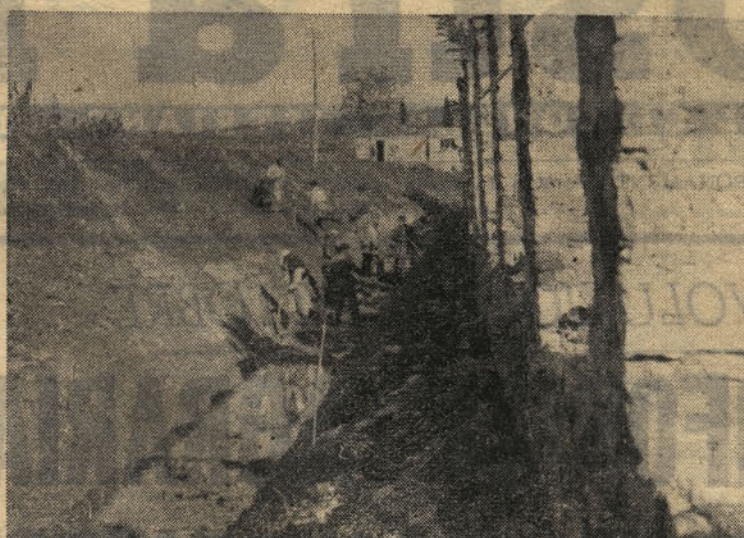
NEL CIRCON. FERVONO I LAVORI SULLE NUOVE COSTRUZIONI
