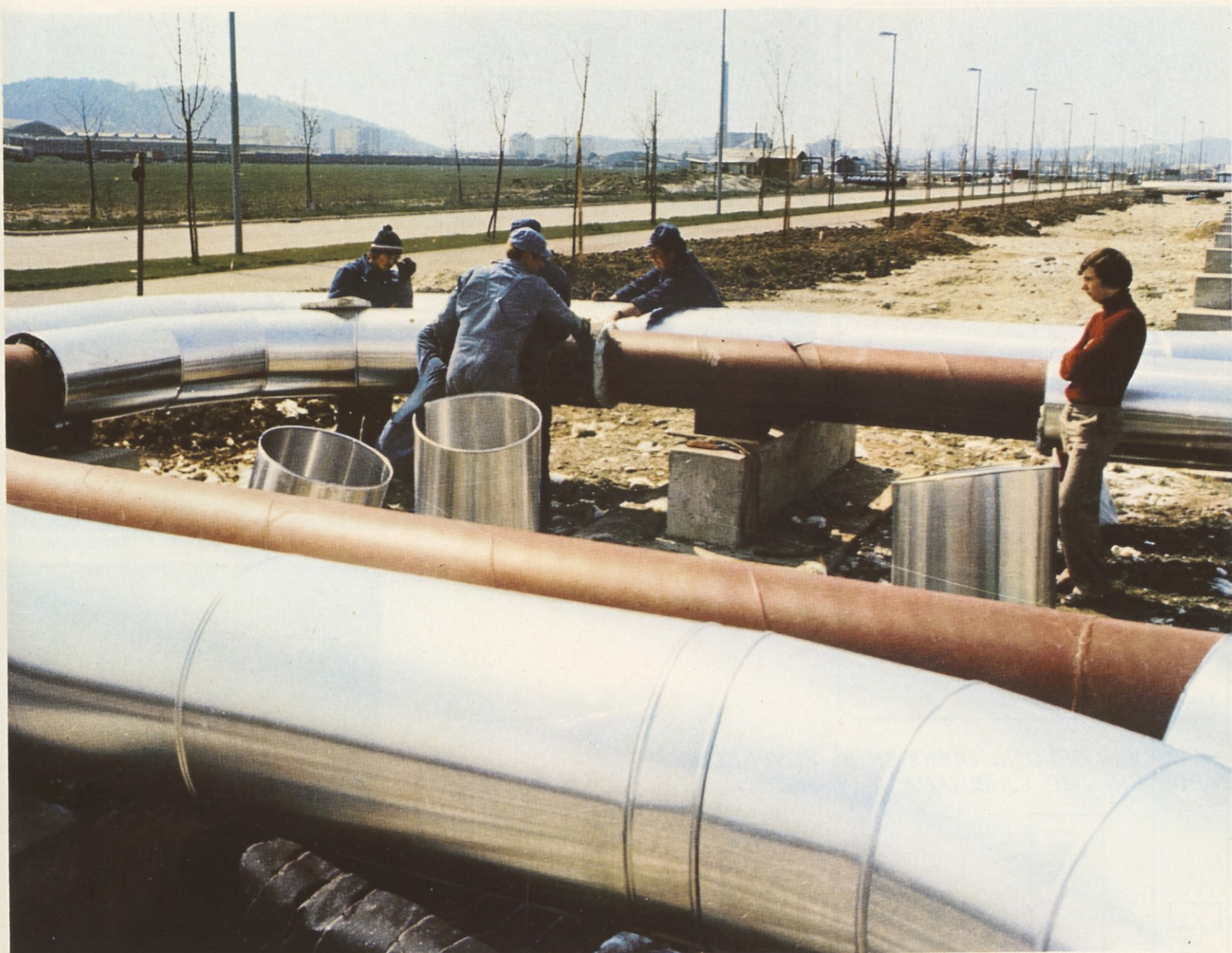
Izolaterji pri delu
