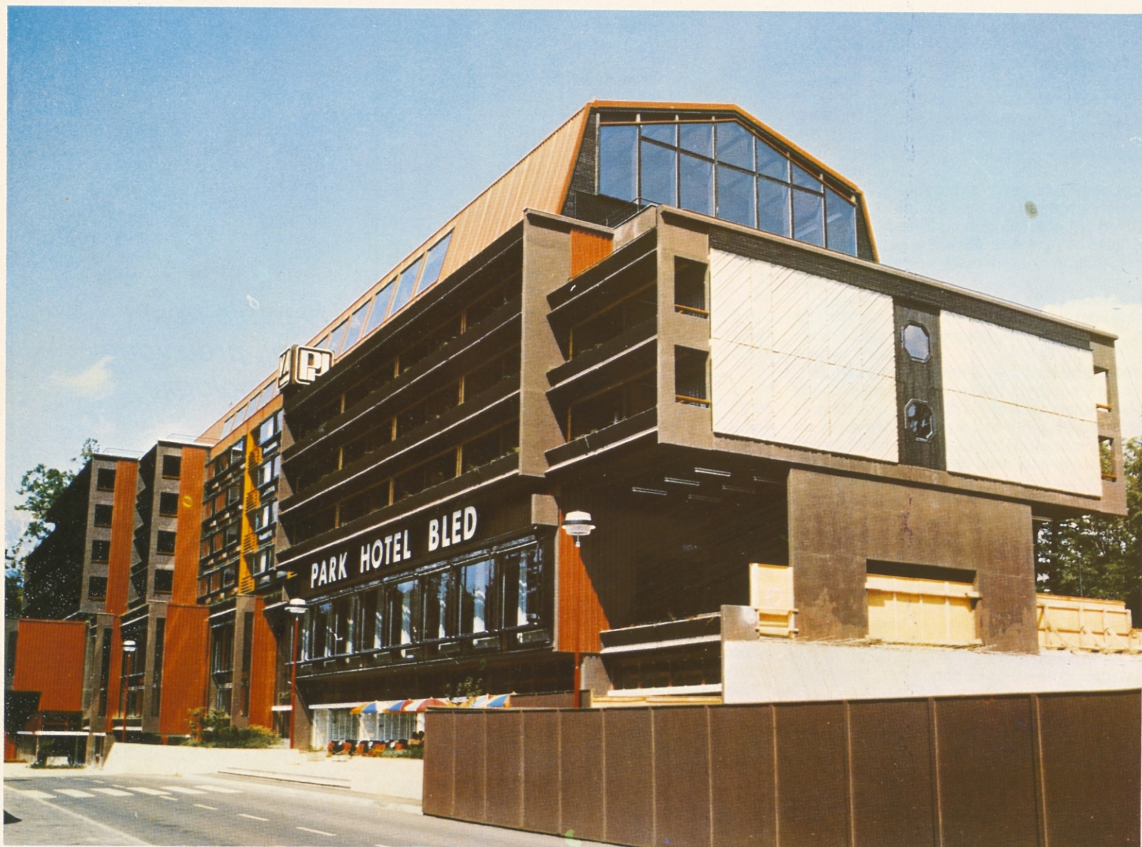
V številne hotele doma in po svetu smo vgradili vse instalacije
