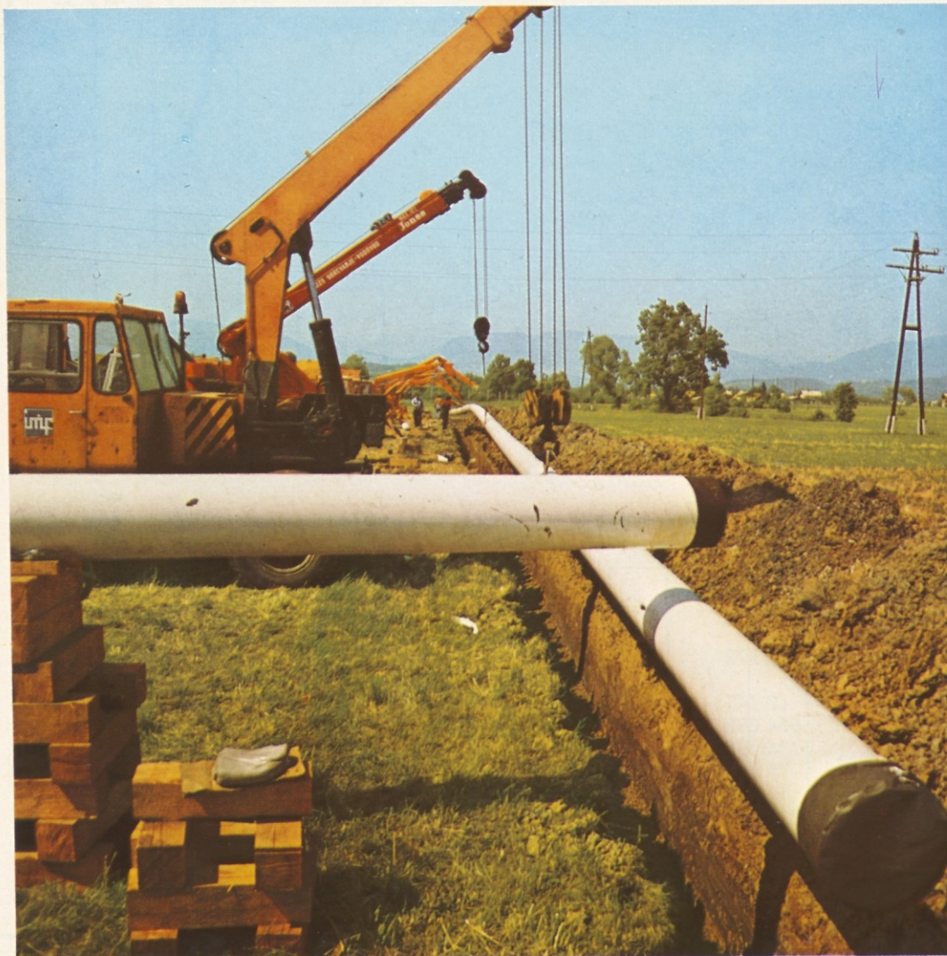
Gradnja plinovoda v Celju
