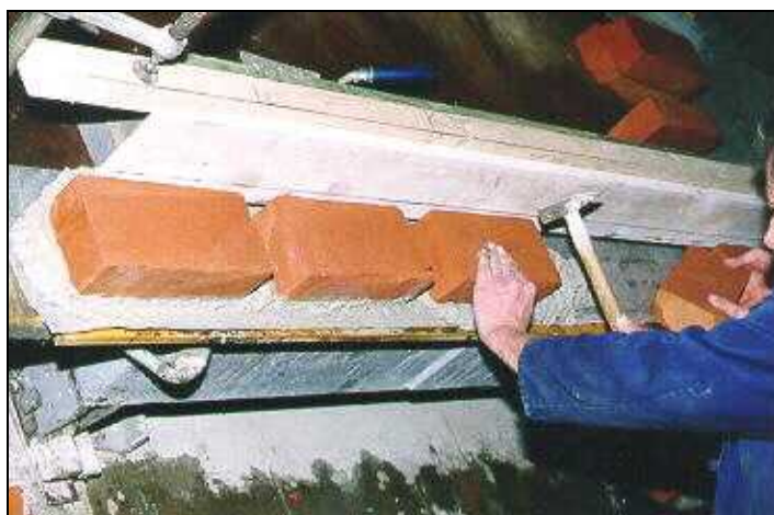
Slika 155: Izdelava vzorcev Fig. 155: Construction of the specimens
