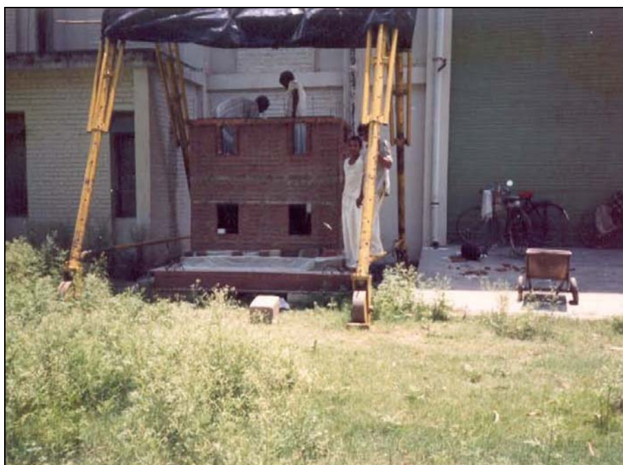
Slika 179: Izdelava druge etaže modela Fig. 179: Second storey construction
