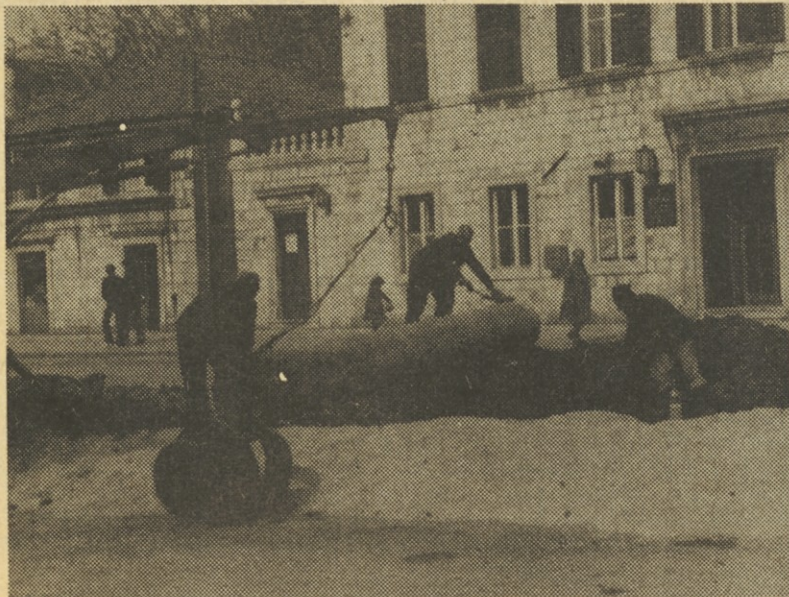
Takole polagajo naši monterji cevovod za kanalizacijo v Dubrovniku
