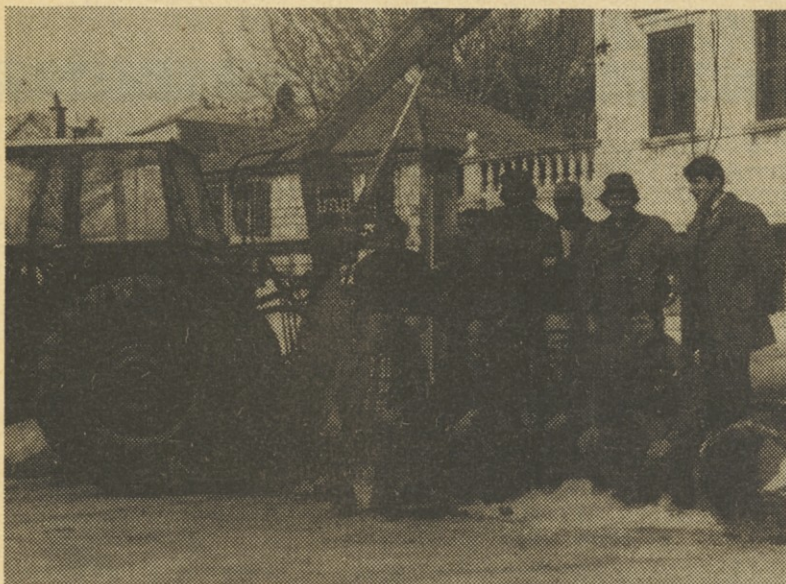
Skupina naših monterjev na gradbišču v Dubrovniku
