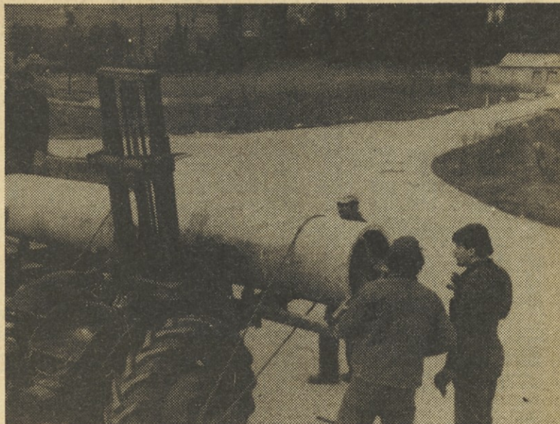
Traktor služi za brušenje koncev cevi
