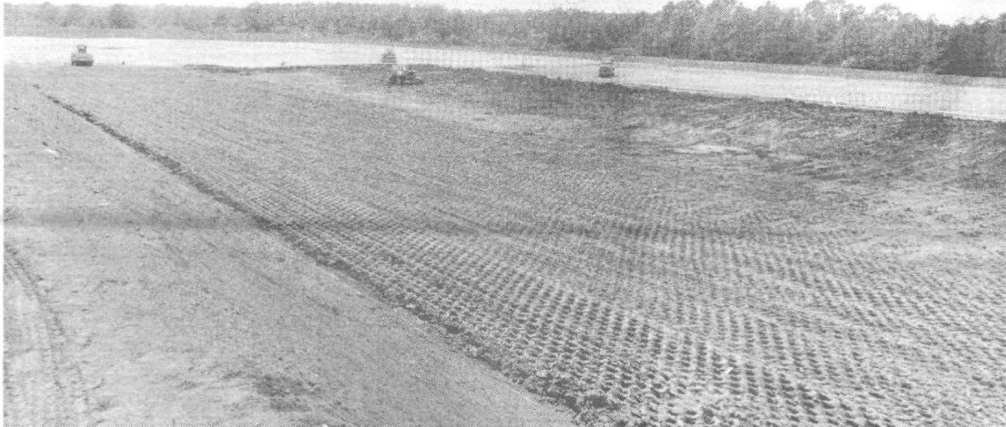
Delo na zaščiti tretjega polja deponije so v teku. Naravni tesnilni slog pred polaganjem je že položen, v teku pa so priprave na polaganje umetnega tesnilnega sloja – folije.
