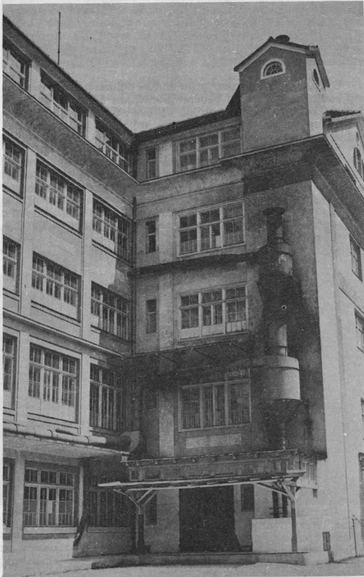
Dogradnja posle prvog rata
