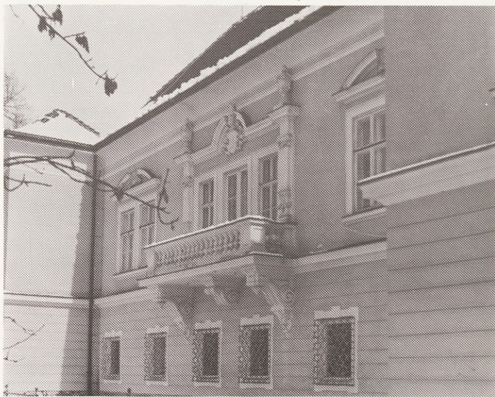
Severna fasada gradu s konzolastim balkonom in trojnim vratnim oknom.
