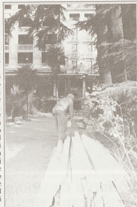
Leta 2003 fiktivni ali resnični začetek priprav na prenavo starega očaka v Portorožu, do katere nikoli ni prišlo. Delavec gradbenega podjetja Strabag pri razkladanju tramov.
