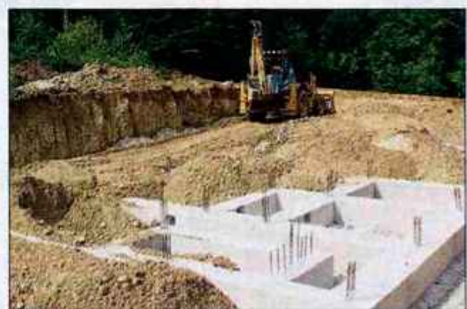
Temelji za bodoči planinski dom v Podborštu so že zgrajeni.
