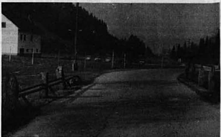
Ob cesti proti Račevi lahko opazite kup uničenih mostnih ograj in prometnih znakov
