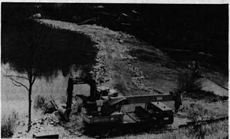
Zahtevna dela na jezu pri Fužinah
