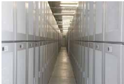
Členi v veliki bateriji v pogorju Tehachapi v Združenih državah Amerike. Po Wikipedii.
