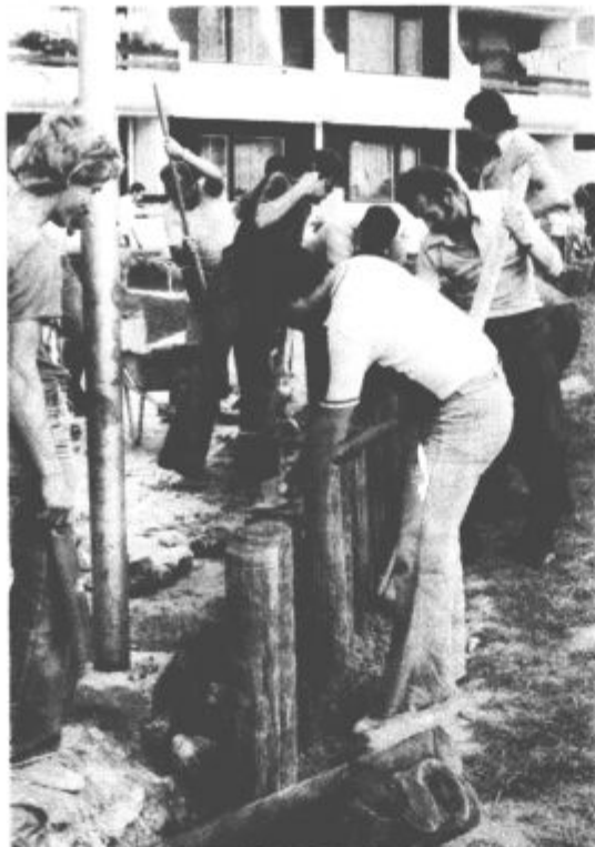
Krajevna skupnost Šalek-Gorica ter samoupravna interesna skupnost otroškega varstva Velenje gradita v soseski Gorica otroško igrišče, ki bo opremljeno z lesenimi elementi. Igrišče bo predvidoma končano konec tega meseca, graditi pa ga pomagajo tudi občani.
