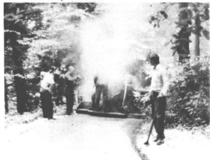
Asfalt tudi na cesti proti Lazam
