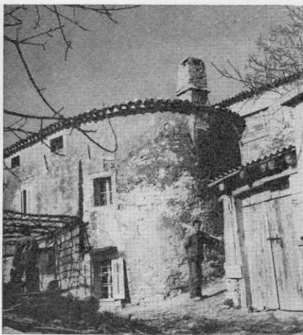
Slika 14. »Trdnjavski« zaključek stavbnega niza na zunanjem robu naselbinskega jedra (hiša št. 51) iz leta 1650 (zasnova je starejša — konec 15. stol.)
