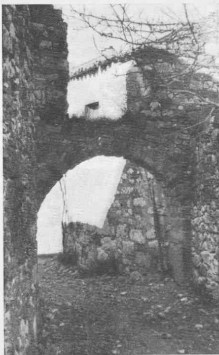
Slika 20. Ruševine hišnega podvoza v ambientu pod cerkvijo
