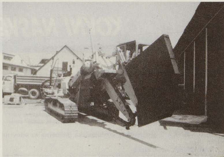
Naša DO Strojna Žalec, TOZD Grames je uvozila iz Velike Britanije »drenmaster« naj sodobnejši stroj za polaganje drenažnih cevi. Tako bomo lahko z DO Minerva, ki izdeluje drenažne cevi, izvajali melioracije v lastni režiji zase in za druge
