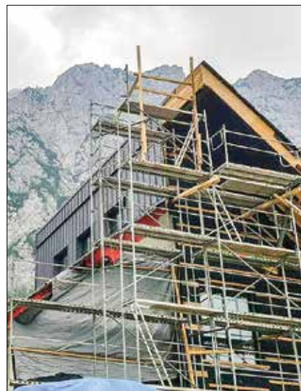
Nova koča bo pol betonska in pol lesena, z najmodernejšimi energetskimi rešitvami.
