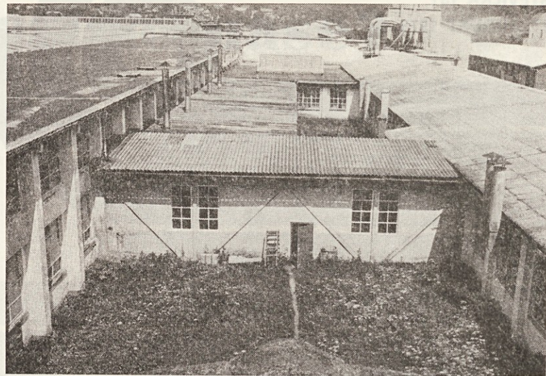
Tu bodo rekonstrukcijska dela v TP Cerknica
