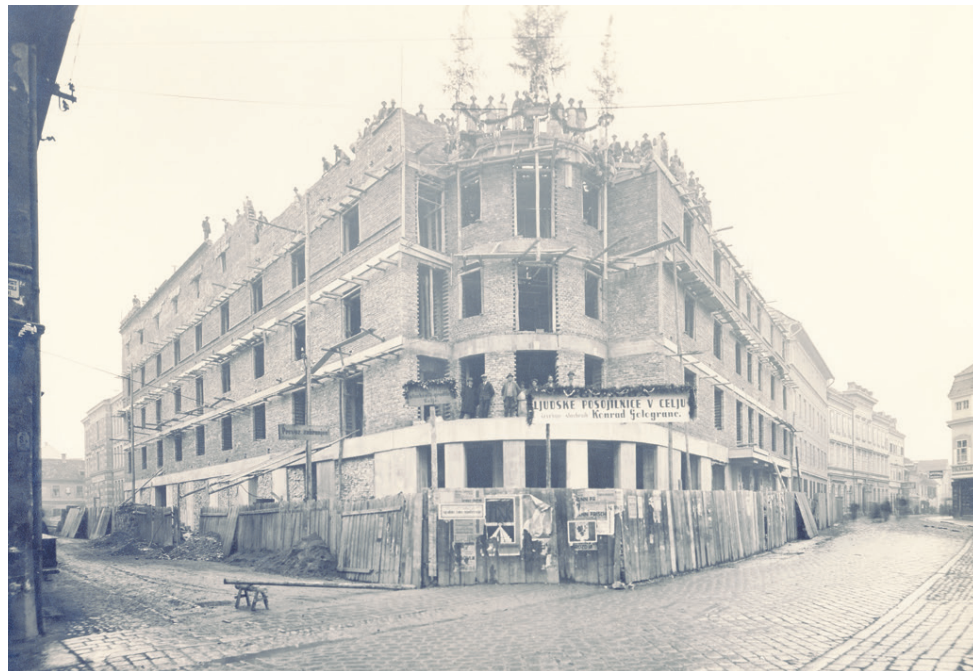
Gradnja posojilnice je potekala pod vodstvom gradbenega inženirja Antona Suhadolca. Dela je izvajalo celjsko gradbeno podjetje Konrada Gologranca. (Foto: MNZC, Pelikanova zbirka)
