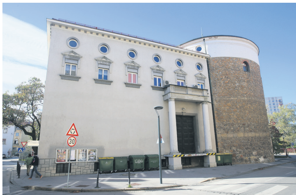
Zadnji del SLG Celje. Premajhna okna je poskušal Plečnik povišati s pomočjo okvirjev iz umetnega kamna, vhod na oder je uredil kot klasični mestni portal z dvema stebroma. (Foto: SHERPA)
