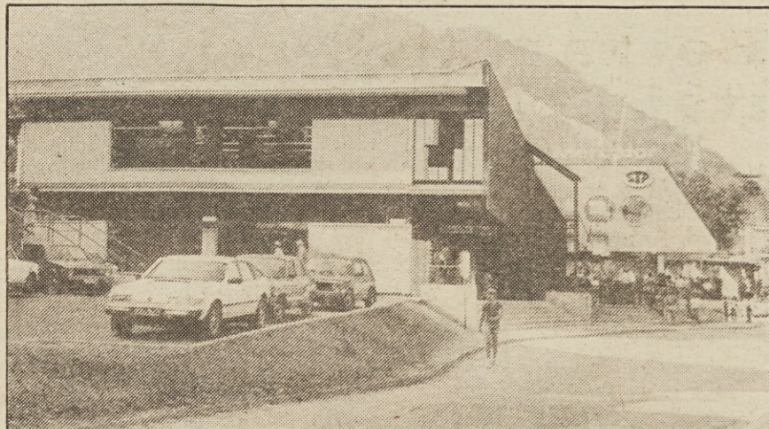
Sprednji (prenovljeni stari del) in zadnji (novi del) blagovnice sta združena v skladno in funkcionalno celoto.
