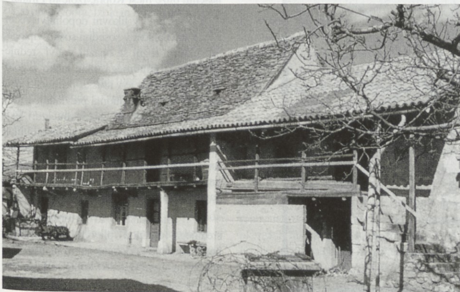
Strma, s kamnito kritino prekrita streha pričča o starosti stavbe (16., 17. stoletje) v naselju Kazlje, ki se je v naslednjih letih stalno razvijala.
