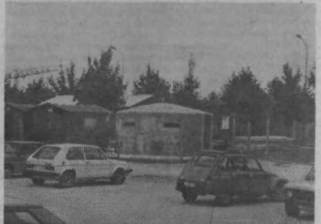
GIPOSS inženiring kot investitor in celjski Ingrad kot izvajalec sta začela pripravljati dela za zidavo garažnega objekta s streho na začetku Trebinske ulice v soseski, ki jo še najbolj poznamo po stari štiri BS-3, zdaj pa sodi v ureditveno območje BS 2/5 – Nove Stožice. Kljub vsem ustreznim dovoljenjem, s katerimi je soglašala tudi krajevna skupnost Ivan Kavčič Nande, pa so okoliški stanovalci zagnali vik in krik, ker takšni gradnji nasprotujejo. Kakšen utegne biti razplet – ali nadaljevanje del ali kaka druga rešitev, primernejša zahtevam krajanov – do zaključka redakcije ni bilo znano, zato bomo o tem poročali tudi v naslednji številki.
