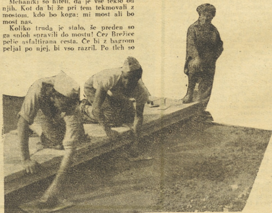
Delo s finišejem (zgoraj). Ob robu cestišča grade pas iz betona (spodaj). Zidarja Avgust Ferko in Ivan Sintič skrbita, da bo cesta gladka in ravna. Po 12 ur na dan na kolenih ni lahko delo (spodaj desno).
