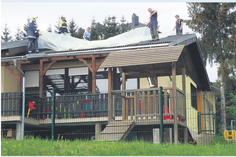
Nič kaj dobro je ni odnesla tudi streha mozirskega vrtca, ki so jo vestni gasilci prav tako prekrili in zavarovali notranjost objekta pred močnim nočnim deževjem, ki je »splaknilo« bele dokaze toče. (Foto: TIMON PT)
