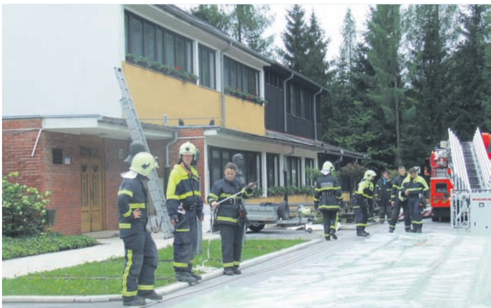
Mozirski in velenjski gasilci na delu pred Osnovno šolo Mozirje. »Kljub temu, da je bila streha dvojno krita, je voda zalila več učilnic. Posledice bodo zagotovo hude,« je omenil poveljnik štaba CZ Jože Zlatinšek, ki je posebej izpostavil požrtvovalnost mozirskih gasilcev.
