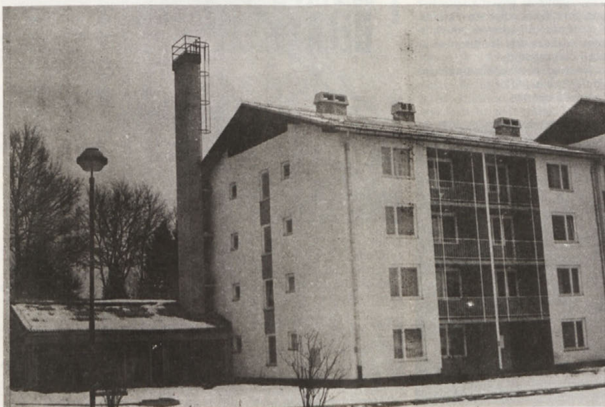
Tudi kurilnica za centralno kurjavo se lahko lepo zlije v celoto s stavbo, kot se lahko pričamo na zgornji sliki, ki kaže upokojski blok na Drski v Novem mestu
