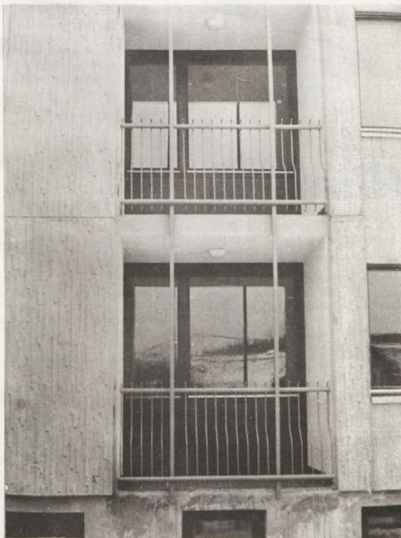
Pogled na detalj 52-stanovanjskega bloka na Drski v Novem mestu. Gradilga je TOZD Gradbeni sektor Novo mesto. Pri tej gradnji so bile prvič v Novem mestu uporabljene pročelne montažne plošče, ki so tudi tu za začetek povzročile nemalo težav
