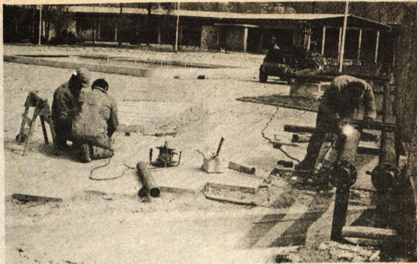
Voda bo ogrevana – Voda v tržiškem letnem kopalnišču bo že v tej sezoni ogrevana. Delavci ljubljanskega IMP napeljujejo toplovod iz tovarne Zlit, ki iz kurjenih odpadkov dobiva več energije kot je sama potrebuje, do bazenov. Delo bo sklenjeno predvidoma čez mesec dni, topli voda pa bo kopalno sezono podaljšala za najmanj dva meseca. – H. Jelovčan
