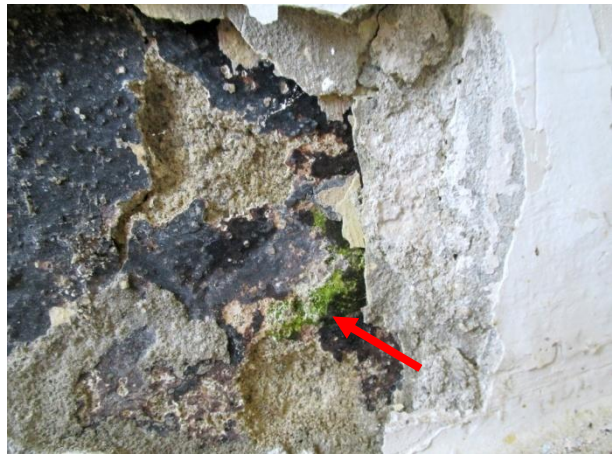
Notranjost – biodegradacija zaradi prekomerne vlage, z rdečo puščico označen mah (30 cm od tal)
