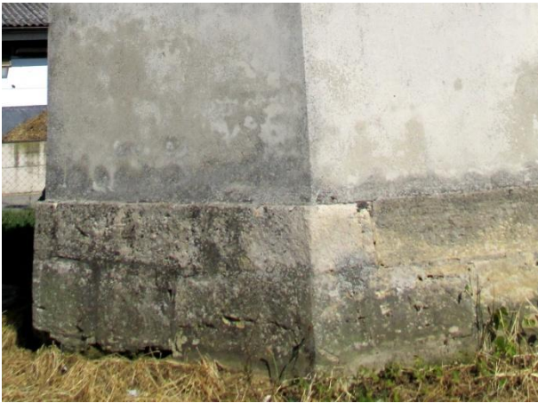
Notranjost – odstopanje in ekspanzija ometov zaradi prekomerne vlage (30 cm od tal)
