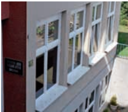
Prek poletja so v osnovni šoli v Smledniku v treh učilnicah zamenjali okna.
