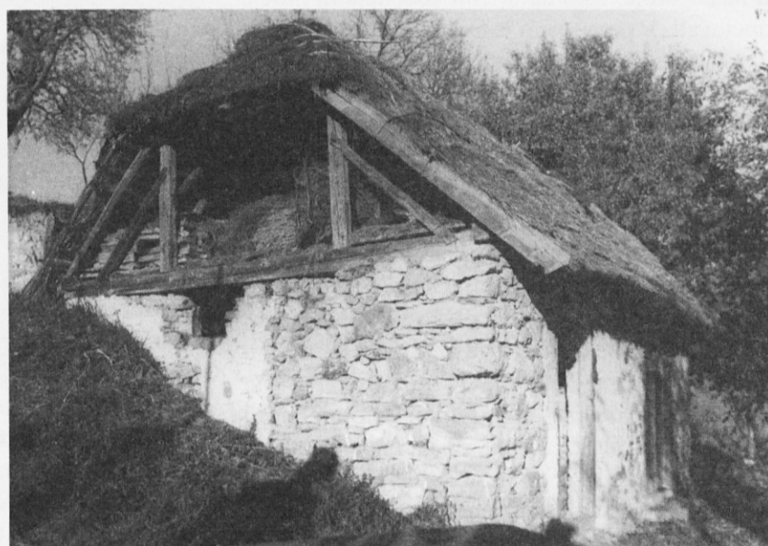
V celoti s kamnom zidana in s slamo krita zidanica - starejši primerek
