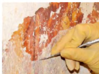
Odstranjevanje sige, mikroinjektiranje, kitanje s fino apneno malto na mestih, kjer je omet odpadel.
