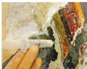
Odstranjevanje sige, mikroinjektiranje, kitanje s fino apneno malto na mestih, kjer je omet odpadel.
