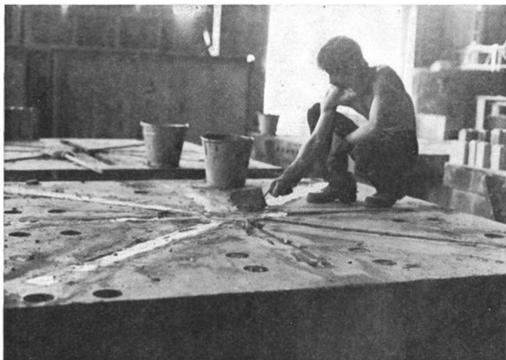
Slika 2 Zidanje plošče Fig. 2 Bricking the plate
