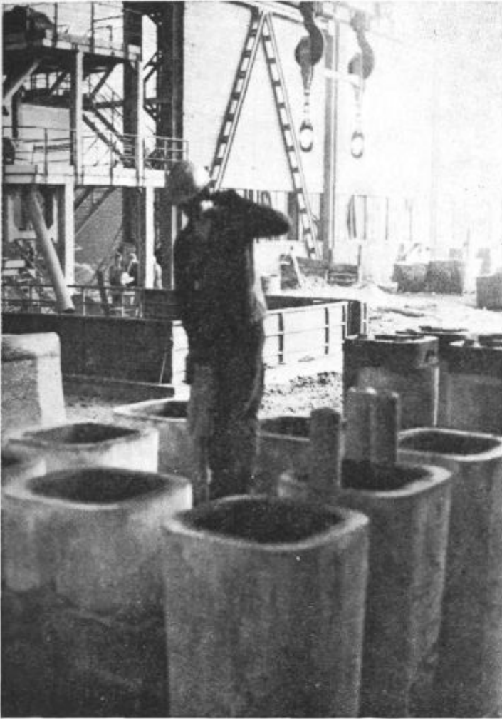
Slika 3 Postavljanje lijaka Fig. 3 Setting the ingate
