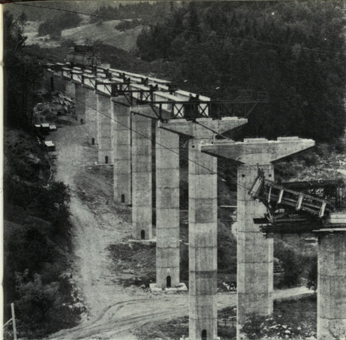
Avtocesta, odsek Hoče—Arja vas Vjadukt SLATINA — 396 m, montaža industrijsko izdelanih nosilcev, (skupno 6 viaduktov v dolžini 2360 m)
