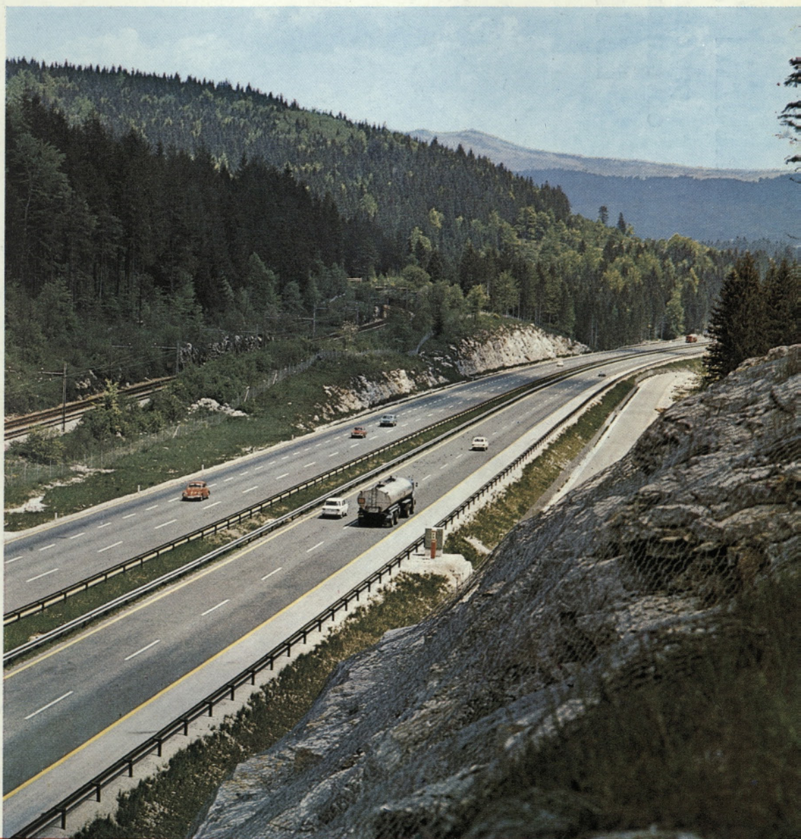
AVTOCESTA NA PODODSEKU UNEC—POSTOJNA Izvajalec SGP »SLOVENIJA CESTE« — Ljubljana (Foto: P. Strnad)
