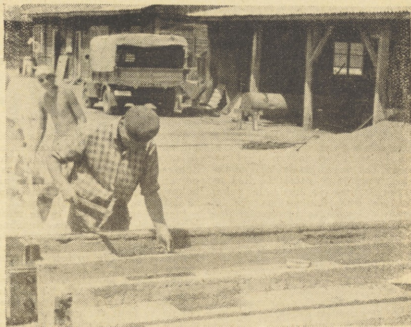
Betoniranje montažnih elementov za prtilične vrstne hišice v Škocjanu pri Kopru
