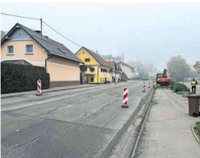
Obnova odseka Ljubljanske ceste na Duplici
