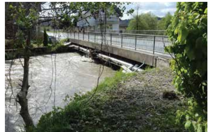
Most v Vrhpolju - zaradi poplav ogrožena vodovodna cev (foto: P. Banovec)
