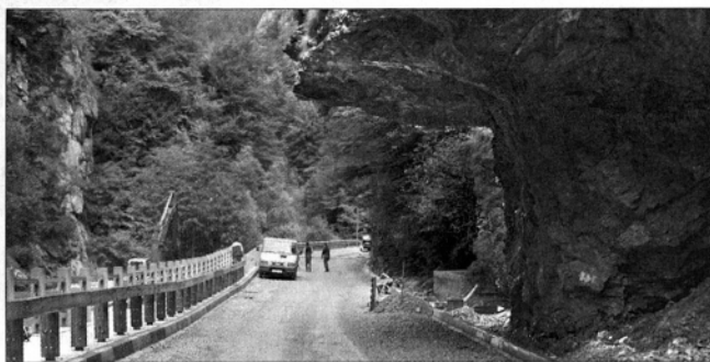
Osrednja gradbena dela na gradbišču pri Igli v občini Solčava gredo uspešno h koncu (foto: Jože Miklavc)
