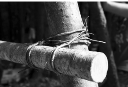
Stražni stolp iz naravnih materialov - namesto vrvi so uporabljene smrekove korenine.
