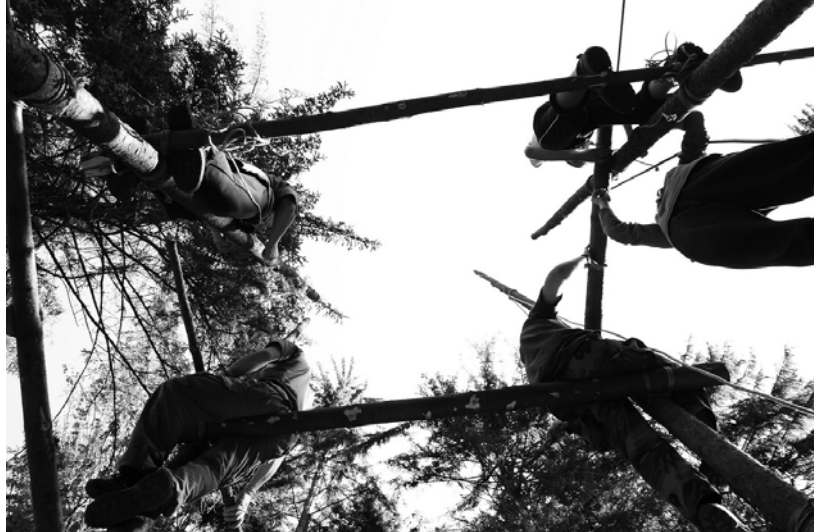
Skupinska gradnja na višini.
