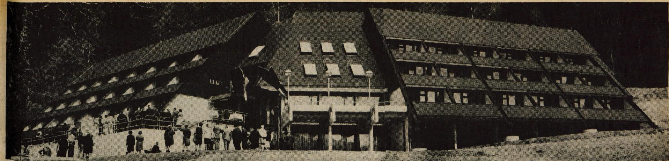
Prizidek Doma Albina Drolca v Potočah pri Preddvoru (odprli so ga v torek, 26. aprila) s 70 ležišči zagotavlja starejšim občanom Kranja sodobno domsko varstvo. — L. M. — Foto: F. Perdan
