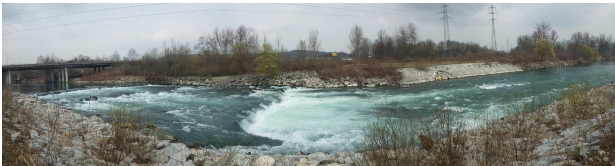
Slika 67: Tristopenjski prag v Šentjakobu (pregrada št. 18).
