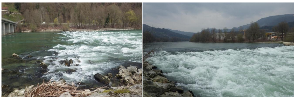
Slika 58: Prag pod mostom v Kresnicah (levo) in prag pri separaciji v Spodnjem Hotiču (desno).
