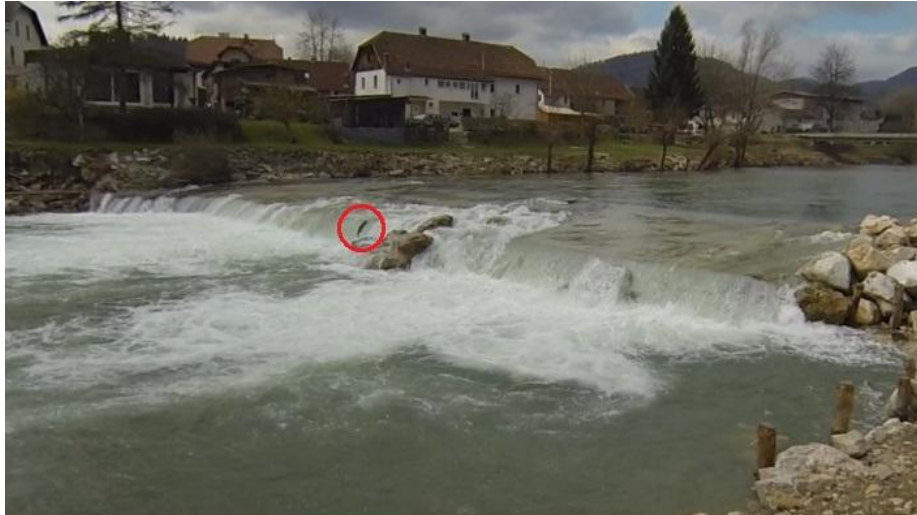
Slika 73: Prag na izlivu Sore v Savo v obstoječem stanju. Na fotografiji je na sredini z rdečim krogom označen sulec, ki želi prag neuspešno preskočiti.
