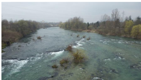
Slika 52: Primer ostankov talnega kamnitega pragu, ki ne segajo preko celotne širine struge in tvorijo prehodne prelive.
