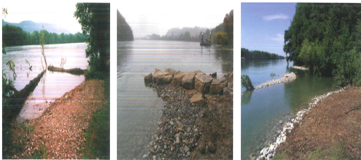
Slika 107: Primeri sonaravnih ureditev brežin na Renu gorvodno od HE Rheinfelden (vir: Gebler, R.J., 2005).
