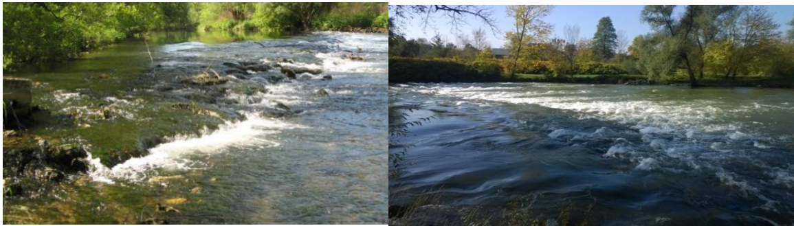
Slika 82: Kamniti prag v Zalogu pred sanacijo (levo) in po sanaciji (desno).
