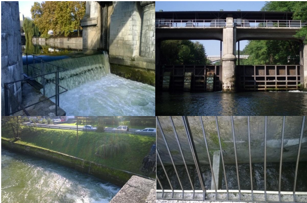
Slika 87: Zapornice pri Ambroževem trgu (zgoraj levo) in na Gruberjevem kanalu (zgoraj desno). Vhod v prehod za ribe (spodaj levo) in tehnični tip prehoda za ribe (spodaj desno) na pregradi pri Ambroževem trgu.
