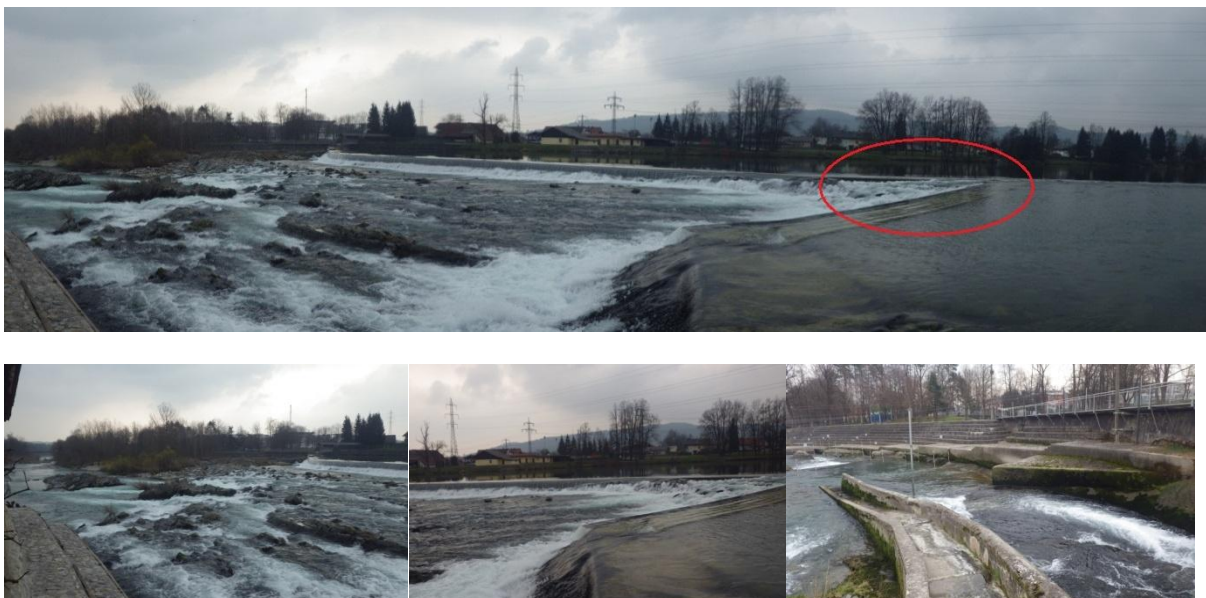
Slika 54: Jez v Tacnu. Hrapava drča v špici jezusa (zgoraj, označeno z rdečo), strme skalnate stopnje pod jezum (spodaj levo), hrapava drča – prehod za ribe v špici jezusa (spodaj sredina) in opuščeni prehod za ribe tehničnega tipa (spodaj desno).
