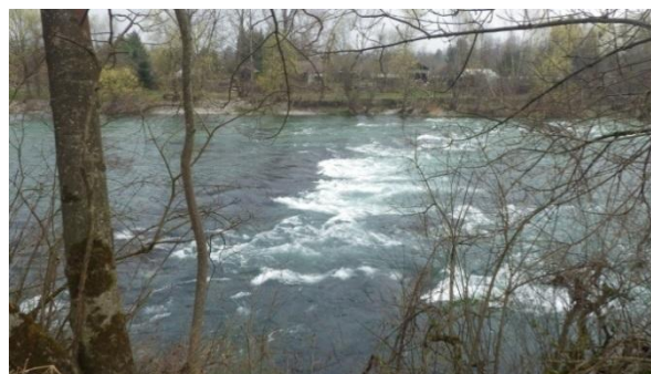
Slika 52: Primer ostankov talnega kamnitega pragu, ki ne segajo preko celotne širine struge in tvorijo prehodne prelive.
