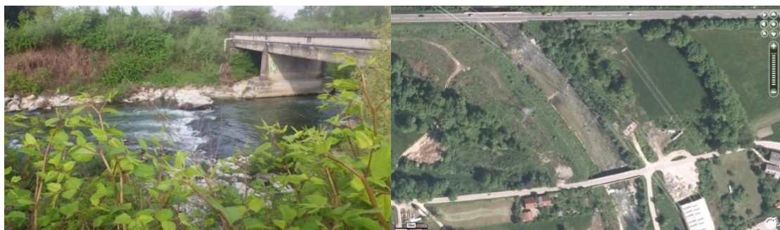
Slika 89: Praga pod cestnim mostom v Beričevem (levo) in odsek Kamniške Bistrice, kjer je za prehajanje, zlasti ob nizkih pretokih, problematičen prenos vodostaj (desno).
