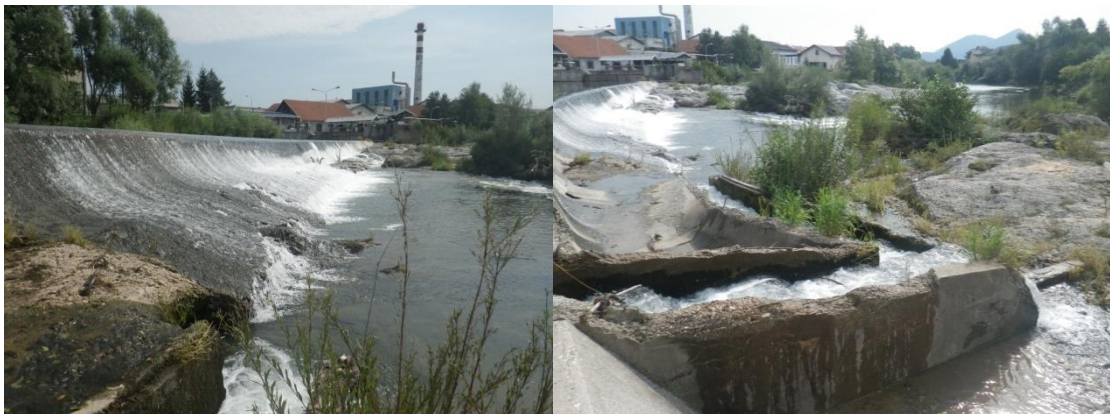
Slika 74: Jezovna zgradba jez v Goričanah (levo) in prehod za ribe na jezovni zgradbi.
