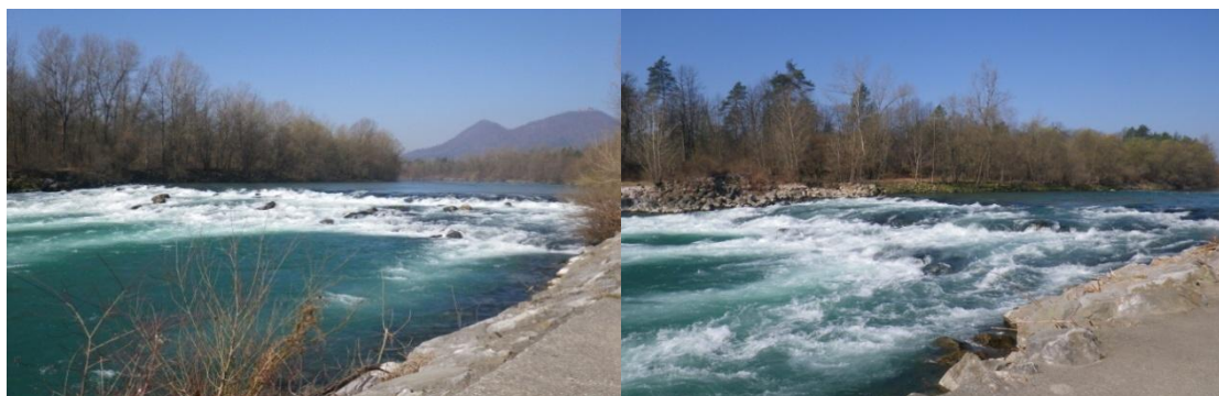
Slika 56: Primera dvostopenjskega kamnitega pragu, ki tvorita hrapavo drčo. Dvojni prag v Spodnjih Gameljnah (levo) in dvojni prag pod izlivom Gameljščice v Spodnjih Gameljnah (desno).
