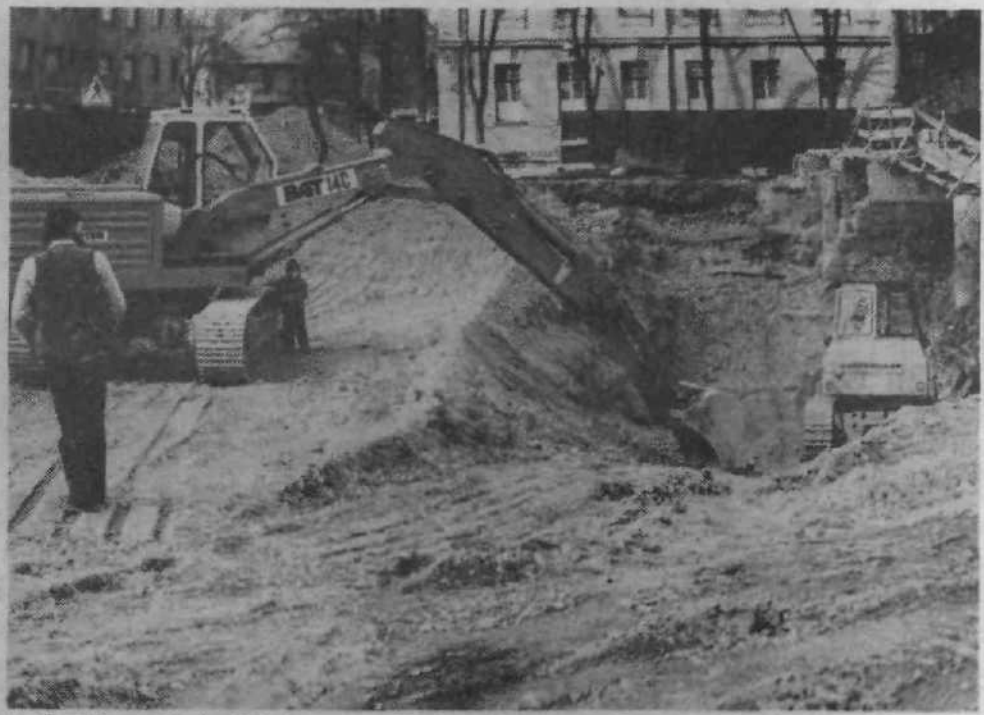
Pred poslovno stolpnico Petroia so se gradbeni stroji zajedli v zemljo na mestu, kjer je nekoč stala postaja milice. Pričeli so z izkopi za dokončno ureditev kolektorja z vsemi napeljavami. Ko bo delo opravljeno, bodo površino asfaltirali in na njej uredili parkirne prostore tako, da bodo vsaj delno odpravili prometni infarkt na tem delu Titove ceste. Tako so opustili zamisel starega zazidalnega načrta, po katerem naj bi na tem mestu uredili prepotrebno zelenico.
