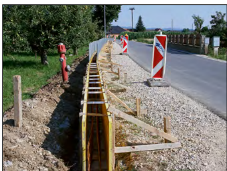
V naselju Draženci se je začela izgradnja pločnika ob lokalni cesti na odcepu nadvoz–kapela. Foto: arhiv občine
