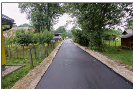
Asfaltirana je tudi javna pot v Slovenji vasi.
